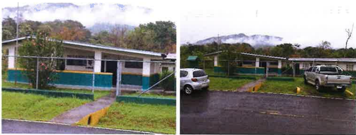
Vistas del Puesto de Salud de La Yeguada
