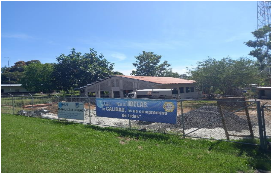
Construcción de UDELAS Las Palmas
